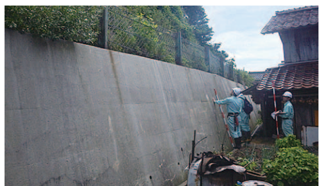
【治山施設点検】
