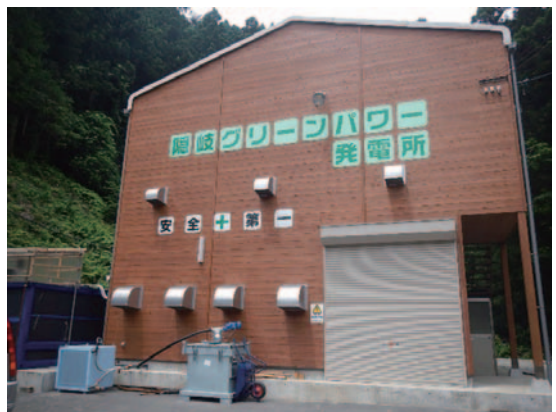
写真2 小型木質バイオマスガス化発電施設
