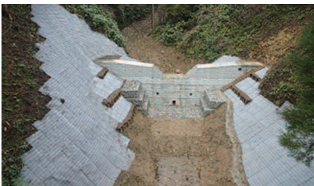
【H28 災害からの復旧状況（溪間対策）】
