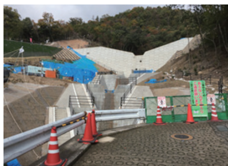
安佐南区緑井地区 砂防堰堤工事中
