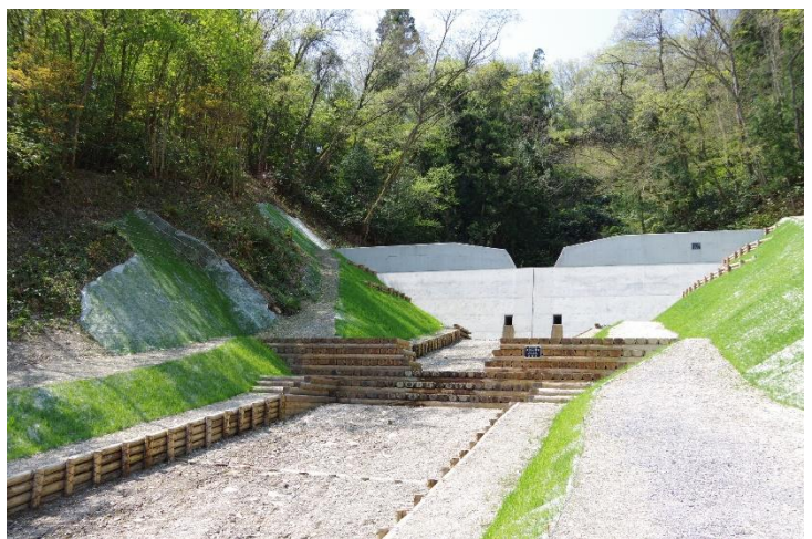
「木を活かした治山ダム」島根県浜田市 鎌田悦史
