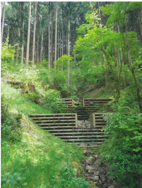
「山になじむ木製ダム」愛媛県松山市 栗林修平
