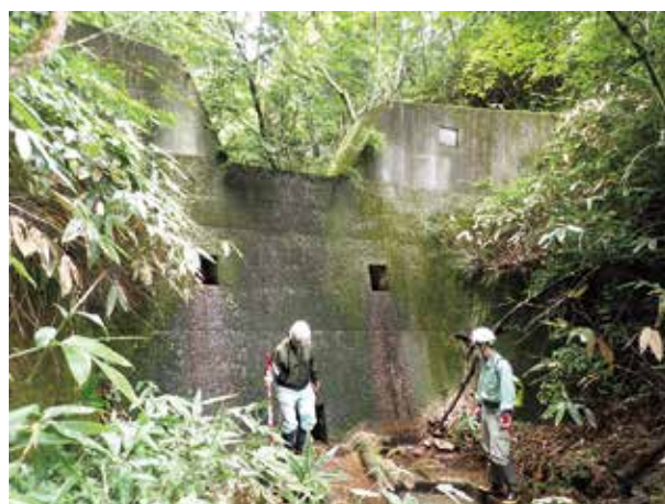
施設点検の様子
