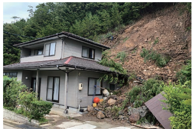
山崩れによる家屋等被災状況（隠岐の島町北方）
