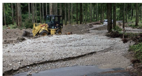
県有林管理スタッフ直営による崩土除去
