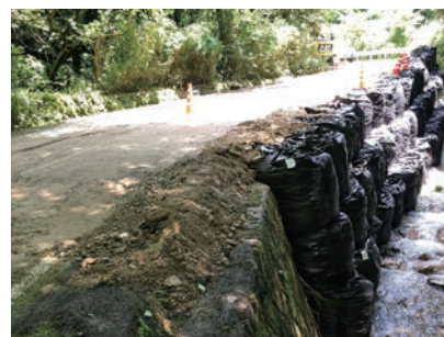
応急工事完了
