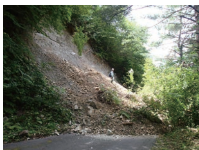
法面の崩壊状況（飯南町）
