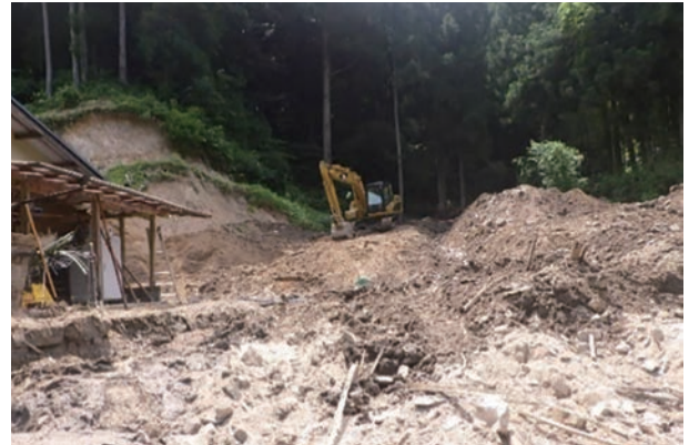
土砂の流出による被災状況（雲南市三刀屋町）
