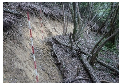
地すべり頭部の滑落崖
