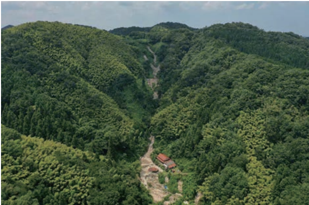
土砂の流出による被災状況（雲南市三刀屋町）
