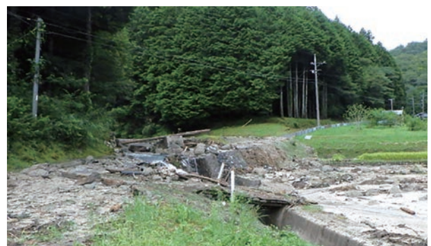
土砂の流出による被災状況（江津市桜江町）
