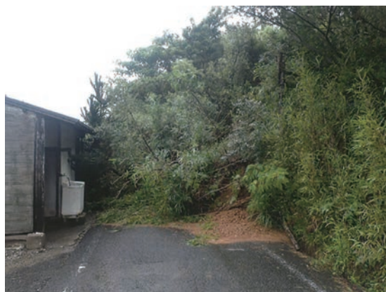
地すべりによる市道等被災状況（隠岐の島町湊）
