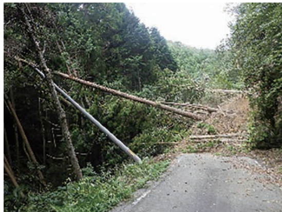
地すべりによる林道被災状況（津和野町富田）
