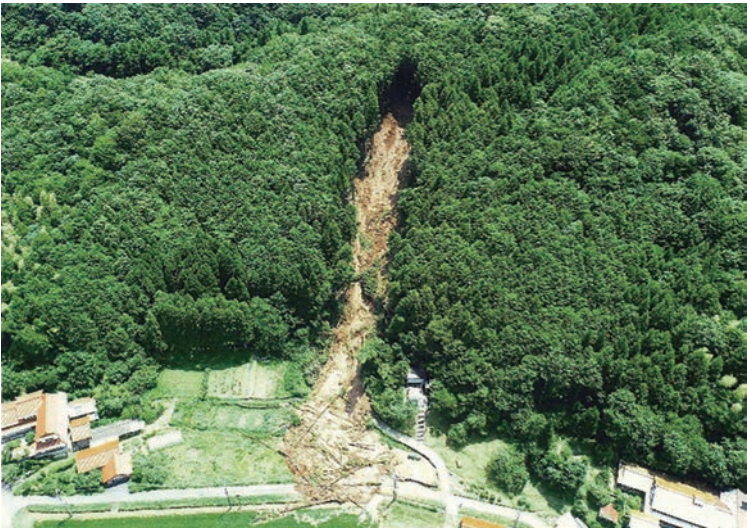
山崩れによる市道被災状況（出雲市古志町）
