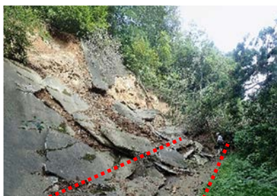
地すべり末端部の押し出し
