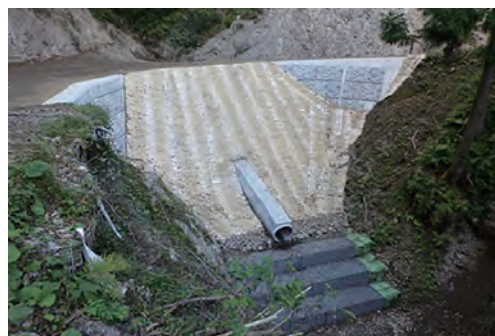
令和3年災 小田支線 復旧状況
