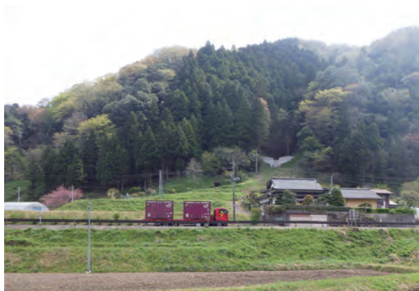
【谷止工による国道や人家の保全（溪間対策）】
