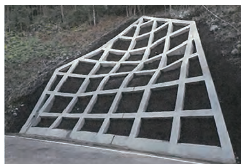
令和3年災 石浦野坂線 復旧状況
