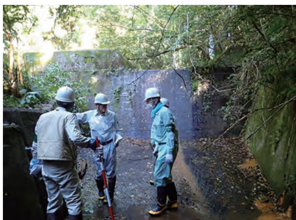
谷止工確認状況（松江市玉湯町地内）
