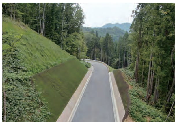
林道開設事業（県営）金城弥栄線
