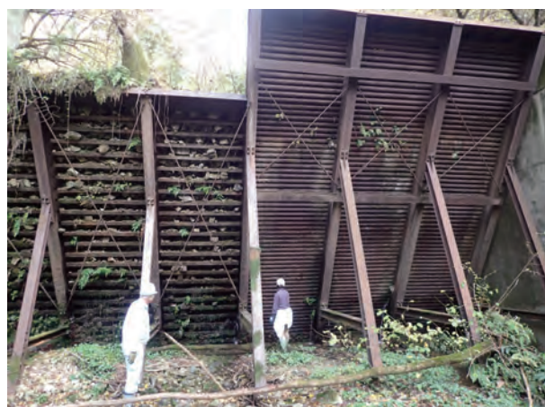
スリットダム確認状況（吉賀町地内）
