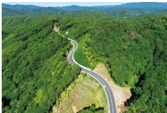
林道開設事業(県営)三隅線
