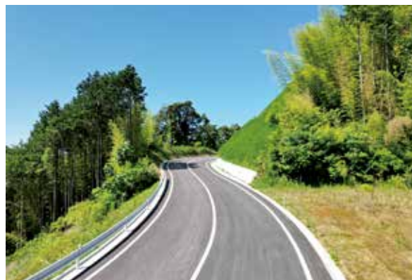
林道開設事業(県営)三隅線 開設状況
