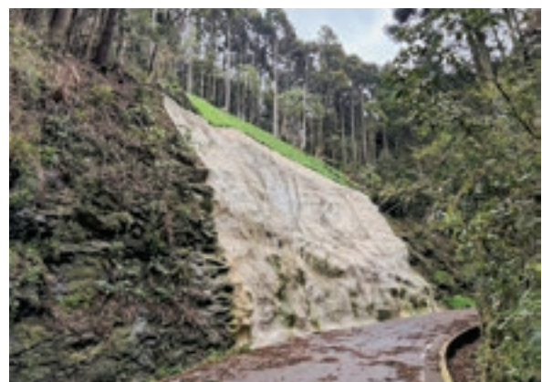
令和6年災 馬見谷線（松江市）復旧完了
