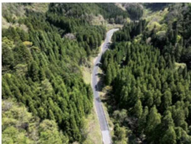
林道開設事業（県営）春日山線 開設状況
