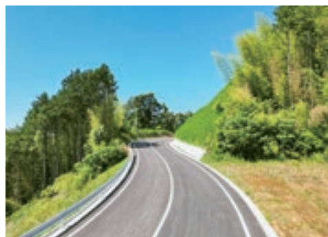
整備した2車線林道
