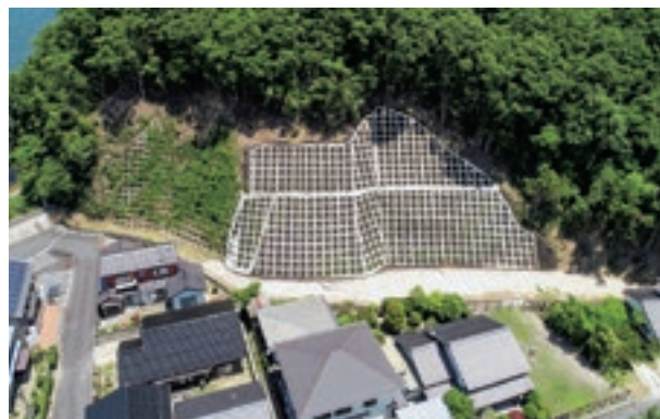
【山腹工による人家及び道路の保全】
